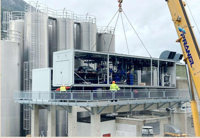
Auf mit Pfeilern abgestützten Fundamenten wurden in luftiger Höhe die drei Module der ONI-Container-Kühlanlage zu einer Einheit zusammengesetzt. Hier wird das 2. Modul der Anlage millimetergenau eingepasst.
