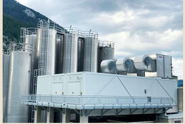
Die komplette Einheit bringt mit mehr als 300 Tonnen Betriebsgewicht einiges auf die Waage. Zur Aufstellung der drei Rückkühlwerke wurde platzsparend das Dach der Container genutzt.
